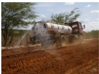
Pavimentação de Vias com Enzimas Biológicas
